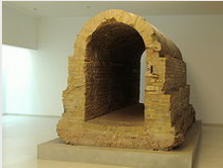
Der unterirdische Rohrleitungsgang
